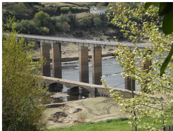
Brücke über den Stausee
