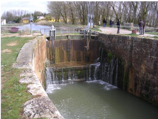
Schleusenanlage vor Frómista
