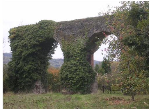
Römisches Aquädukt an der Mosel
