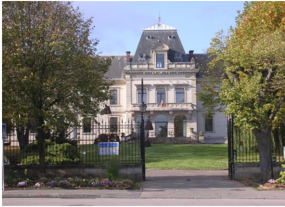
Regierungsgebäude in Nancy
