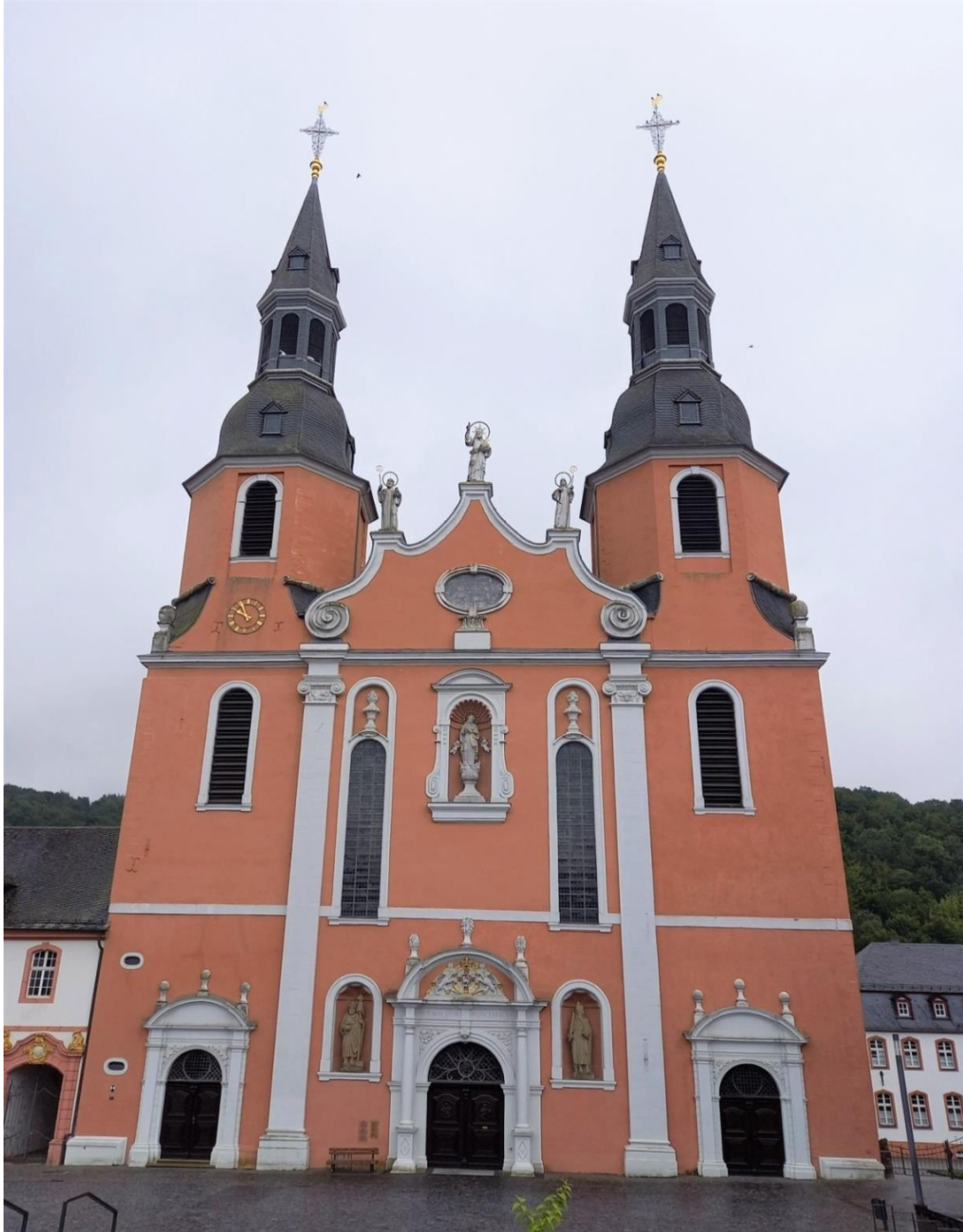
St. Salvator in Prüm
